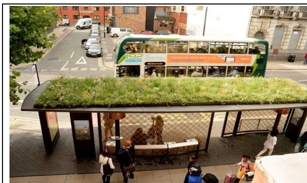
Città/Stato: Manchester, Regno unito Nome del Progetto: Pensilina a Piccadilly Fonte: www.designweek.co.uk/issues/26-september-2-october-2016/new-digital-bus-shelter-design-piloted-manchester/
